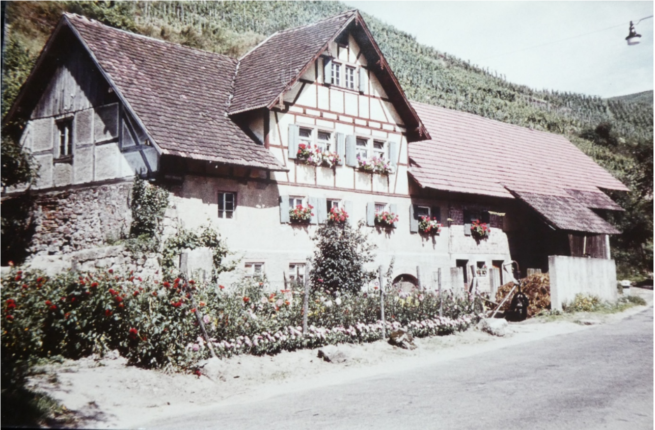
Das Anwesen der alten Pochmühle. Auf der linken Seite war die Mühle angebaut. Der Hausspruch war am Giebel unterhalb der Speicherfenster angeschrieben.
