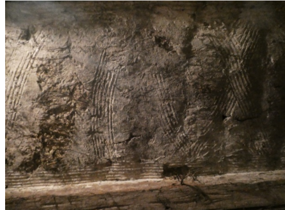
Kellerdecke des alten Wohnhauses Färberei Plank
